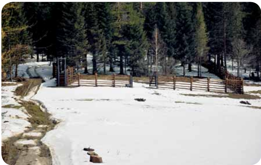
Fot. 12. „Świeżo” wybudowana odłownia dla żubrów w I-ctwie Kołonice, Nadl. Baligród
