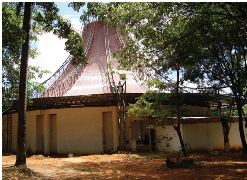
Areguá – budowa Centrum Miłosierdzia Bożego
