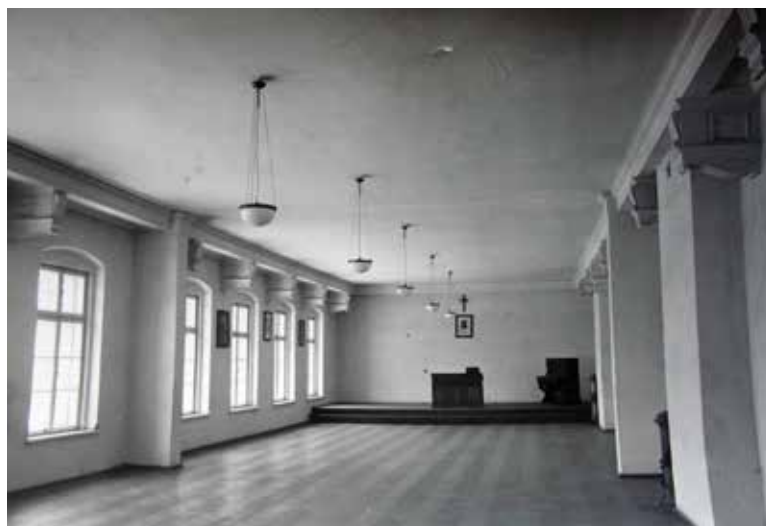
Prace budowlane przy Uniwersyteckim Centrum Medialnym (poniżej; fot. Anna Swęda), powstającym w dawnej auli imienia Piusa XI (stan z lat 20. XX w., fot. BU KUL)
