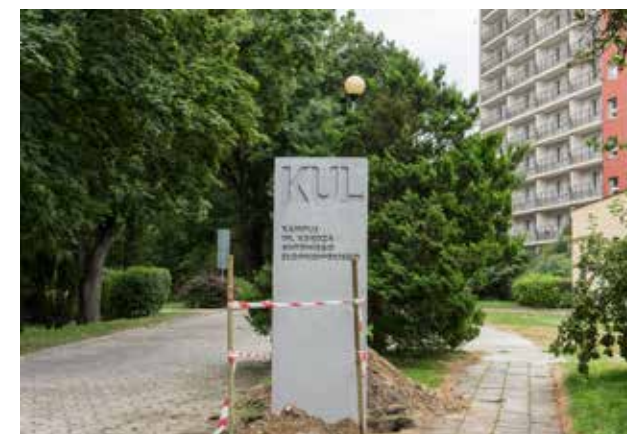
Montaż murków z nazwą kampusu przy wjazdach na Poczekajkę
