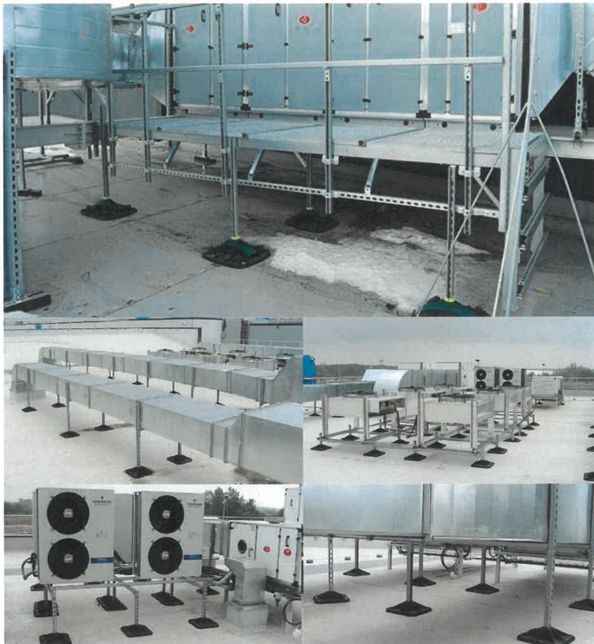
Przykładowe rozwiązanie posadowienia dachowego wg systemowych rozwiązań.
