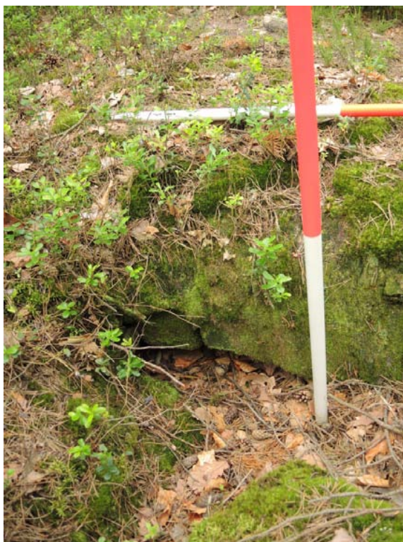
Fot. 12. Fragmenty murowanego nadproża - domniemanego wejścia do sztolni (?) – Nadleśnictwo Starachowice (oprac. R. Zapłata)
